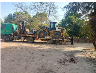
De bulldozer arriveert eindelijk
